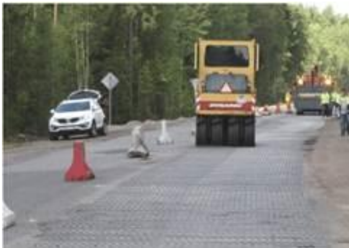
Рисунок 10.5 - Прикатка сетки пневматическим катком
