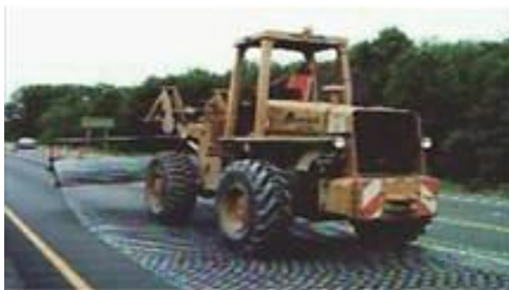
Рисунок 10.1 - Укладка стальной сетки
