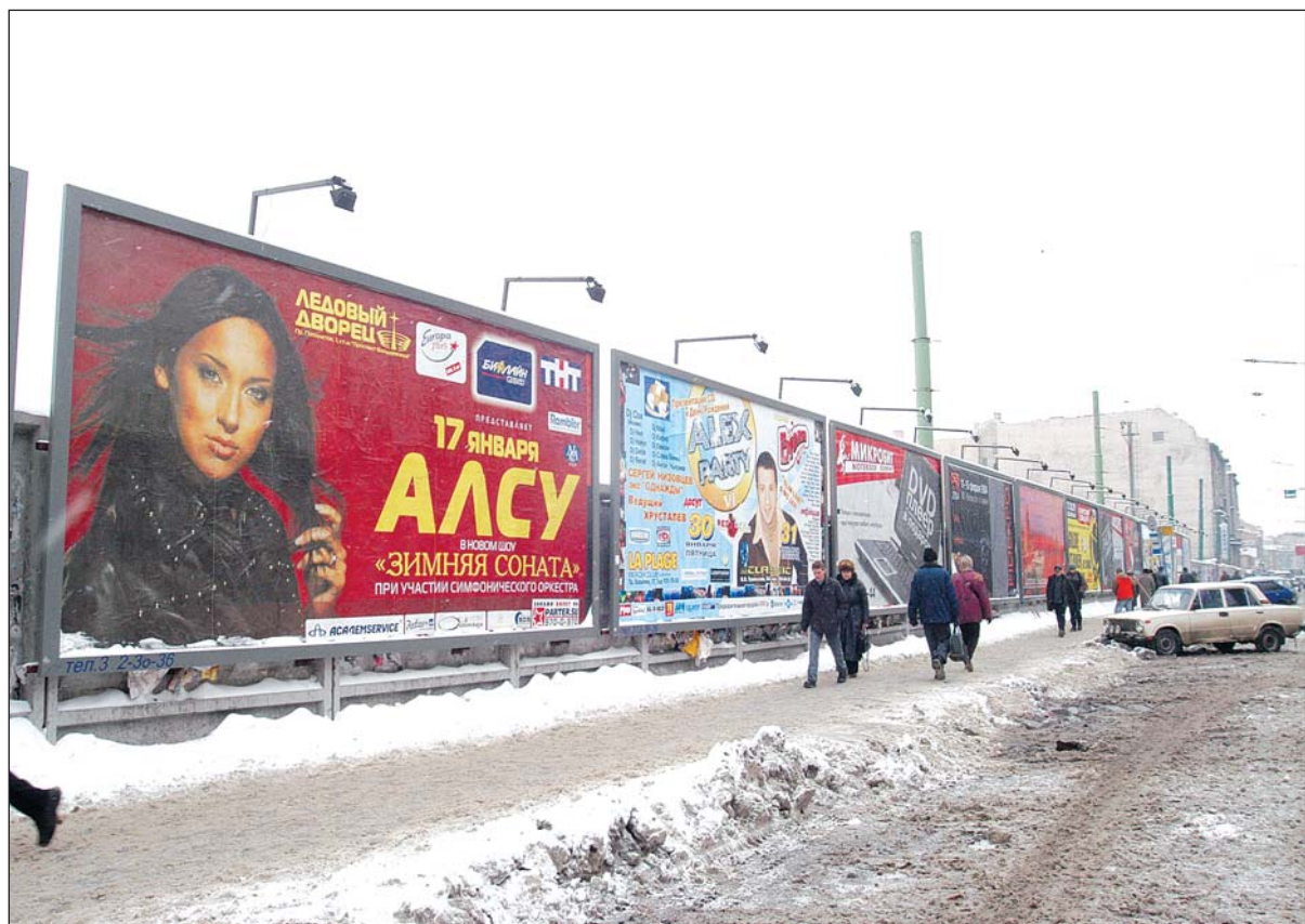
Самую большую в Санкт-Петербурге строительную яму окружили специальным забором, который удачно используется для рекламы
