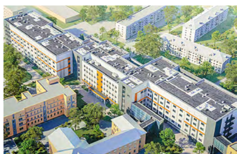
Новый корпус больницы № 40
