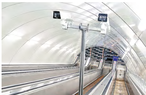
Станция «Чернышевская» после реконструкции
