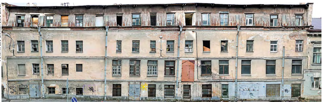
Кожевенная линия, строение 3
