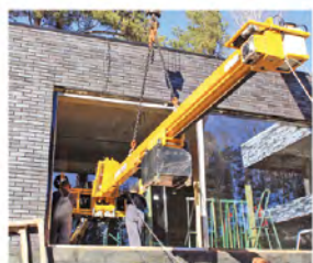
Монтаж под козырек
