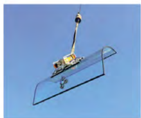
Монтаж радиального стекла
