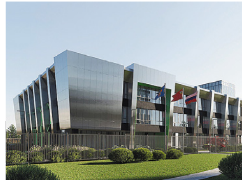
Москва, школа с наклонными пилонами из металлических профилей на фасадах в ЖК Upside Towers
