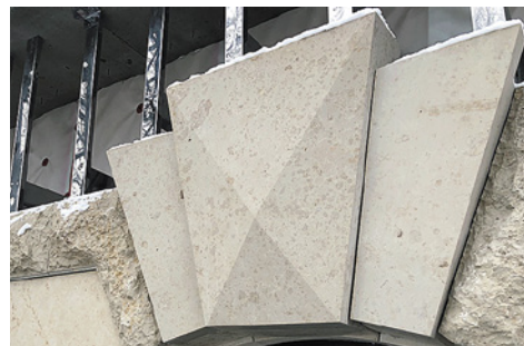
Подсистема DIAT из нержавеющей стали для фасада ЖК «Морская резиденция»
