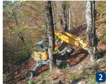
1, 2, 3 – устройство нагельных полей в труднодоступных условиях
