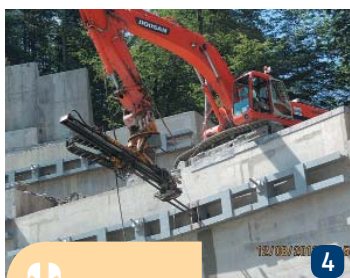
4, 5 – устройство анкеров систем подпорных стен; 6 – построенная 17-километровая дорога к биатлонно-лыжному стадиону
