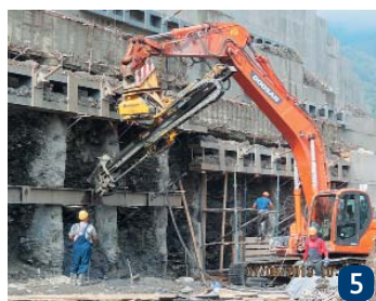
4, 5 – устройство анкеров систем подпорных стен; 6 – построенная 17-километровая дорога к биатлонно-лыжному стадиону
