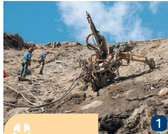
1, 2, 3 – устройство нагельных полей в труднодоступных условиях
