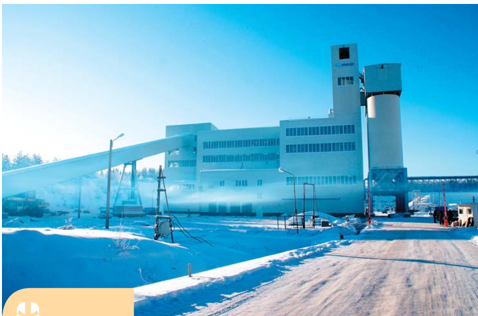
Горнообогатительная фабрика, пос. Неболчи Новгородской области
