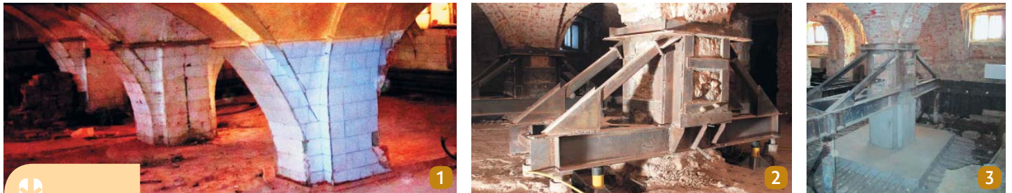
1) Вид кирпичных колонн цокольного этажа до начала работ по реконструкции. 2) Установка гидравлических домкратов для «вывешивания» колонны. 3) Бетонирование новых железобетонных фундаментов
