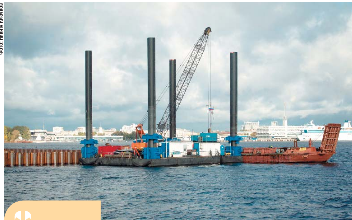
Временные технологические эстакады, построенные на 57%, помогут подвозить строительные материалы и оборудование к «водным» частям ЗСД
