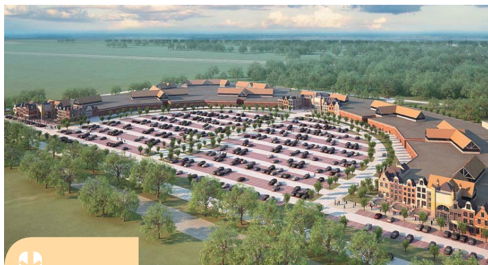
Строительная площадка FASHION HOUSE Outlet Centre St. Petersburg находится на участке площадью 12 га в Ломоносовском районе на границе Петербурга и Ленинградской области
