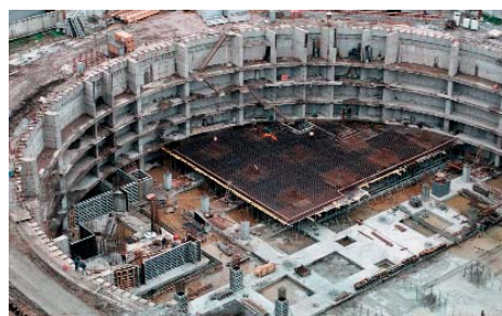
ТРЦ «Атмосфера» на Комендантской площади. Строительство пятиэтажного подземного паркинга
