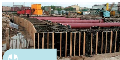
Устройство элемента въезда и выезда тоннеля на левом берегу Невы
