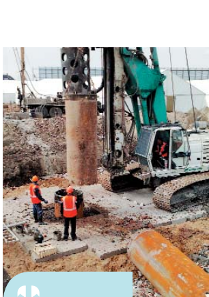
Испытание барретт и свай на нагрузку до 3500 т
