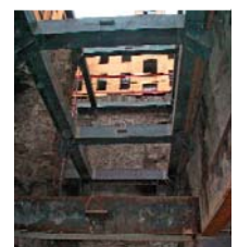
Устройство многоуровневого подземного паркинга рядом с исторической застройкой на набережной реки Мойки
