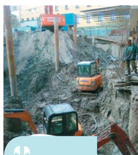
Устройство многоуровневого подземного паркинга рядом с исторической застройкой на набережной реки Мойки
