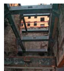
Устройство многоуровневого подземного паркинга рядом с исторической застройкой на набережной реки Мойки
