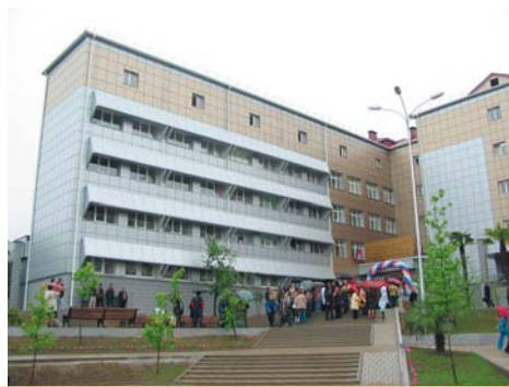
Городская поликлиника № 1 до и после реконструкции. г. Сочи, ул. Абрикосовая, 19а. Система вентилируемого фасада с облицовкой фасадными кассетами
