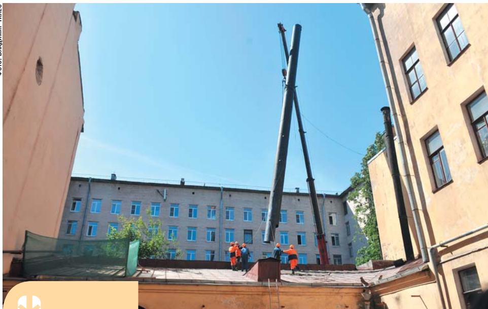
В Центральном и Адмиралтейском районах в ближайшие 5 лет демонтируют 140 старых дымовых труб и установят всего 40 новых
