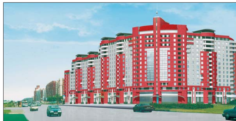
Дом в урбанистическом стиле возводится на Ленинском проспекте
