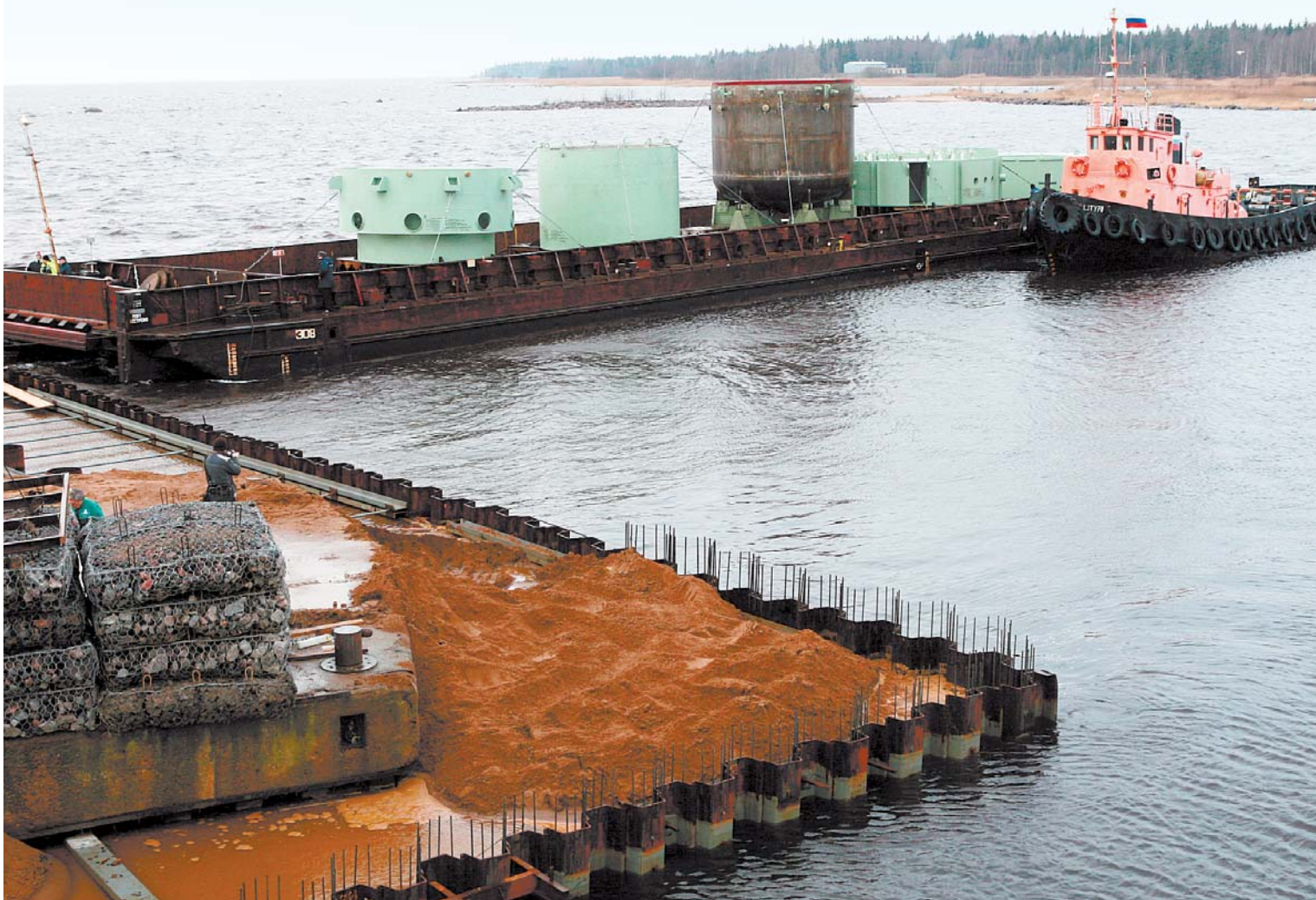
Сверхтяжелое – более 800 тонн – устройство локализации расплава прибыло по воде в Сосновый Бор и будет почти полгода устанавливаться на строящейся ЛАЭС-2. Для доставки «ловушки» в городе была создана дополнительная транспортная инфраструктура – пирс и технологический мост через реку Коваш.
