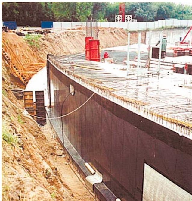
Подземные конструкции нуждаются в надежной гидроизоляции
