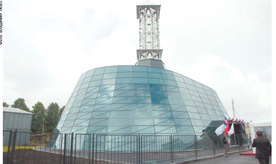
Облик котельной, выполненной в виде синеватого стеклянного эллипса, напоминает инопланетный космический корабль
