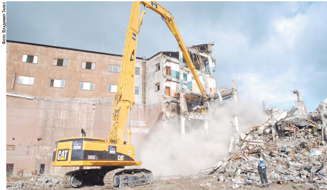
→ Механизированное обрушение с помощью специальной тяжелой техники малоэффективно с точки зрения дальнейшей утилизации строительного мусора
