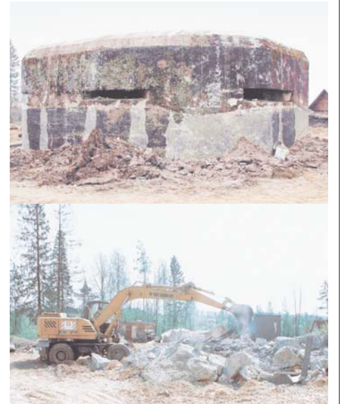
Демонтаж железобетонного дота в садоводстве
