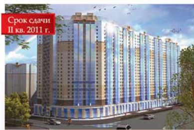
Жилой комплекс на углу Северного пр. и ул. Есенина
