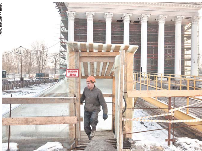
По мнению экспертов, проект подземного строительства под Каменноостровским театром достоин любого европейского геотехника
