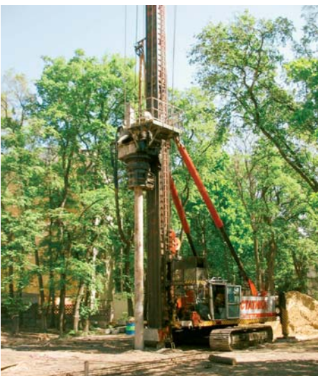
Раскатка скважины с помощью буровой установки Junttan PM 26-40
