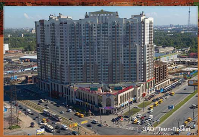
КОЛОМЯЖСКИЙ пр., 15 (IV очередь)
