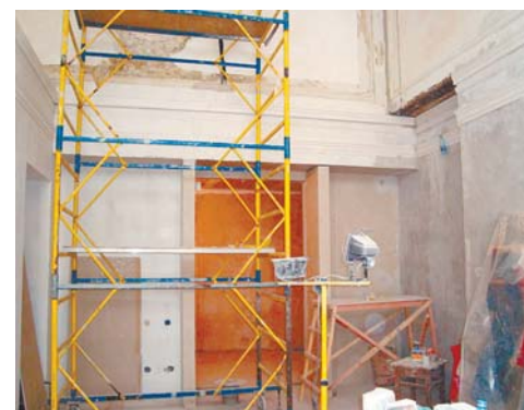
Ремонт первого этажа
