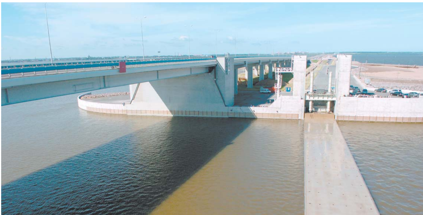
Рядом с разводным мостом комплекса С-2 из воды показался многотонный затвор. В течение получаса он поднимается с 20-метровой глубины, чтобы почти четырехметровой стеной защитить город
