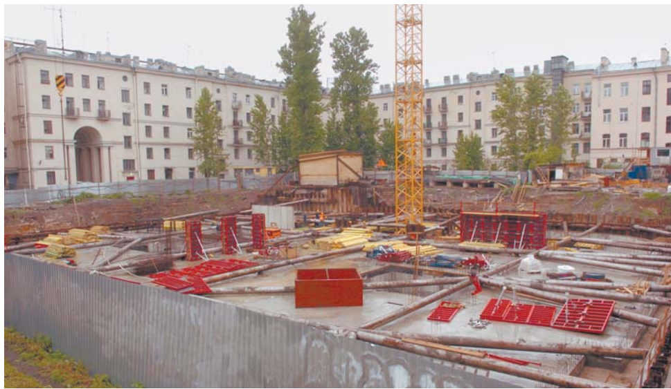
Сдача в эксплуатацию жилого дома юго-восточнее дома 16, лит. А по улице Комсомола переносится с мая 2008 года на сентябрь 2009 года
