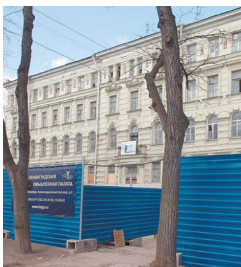
Здание на Конногвардейском бульваре, 5 реконструируется под гостиницу
