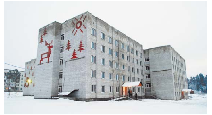
Новый 43-квартирный дом в Подпорожье
