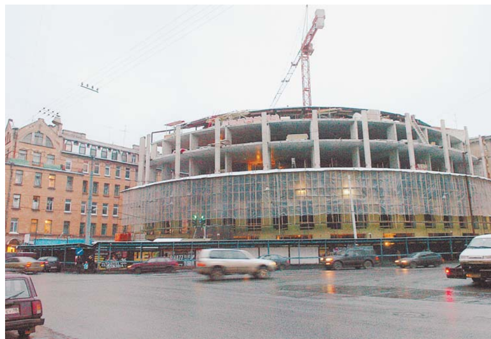
Сейчас каркас здания торгового центра на Рыбацкой улице построен полностью, на 15 процентов выполнены специальные внутренние работы и проложены инженерные сети
