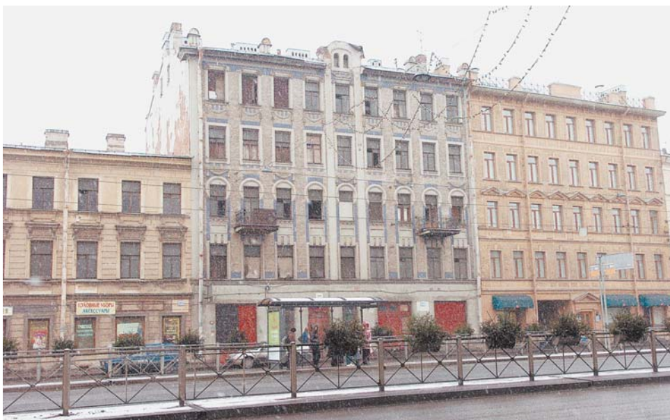
По Лиговскому проспекту идет реконструкция нескольких зданий под гостиницу «Комфитель»
