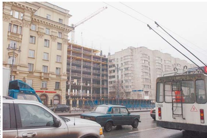
На Московском проспекте строится гостиница. Уже готовы 7 этажей здания
