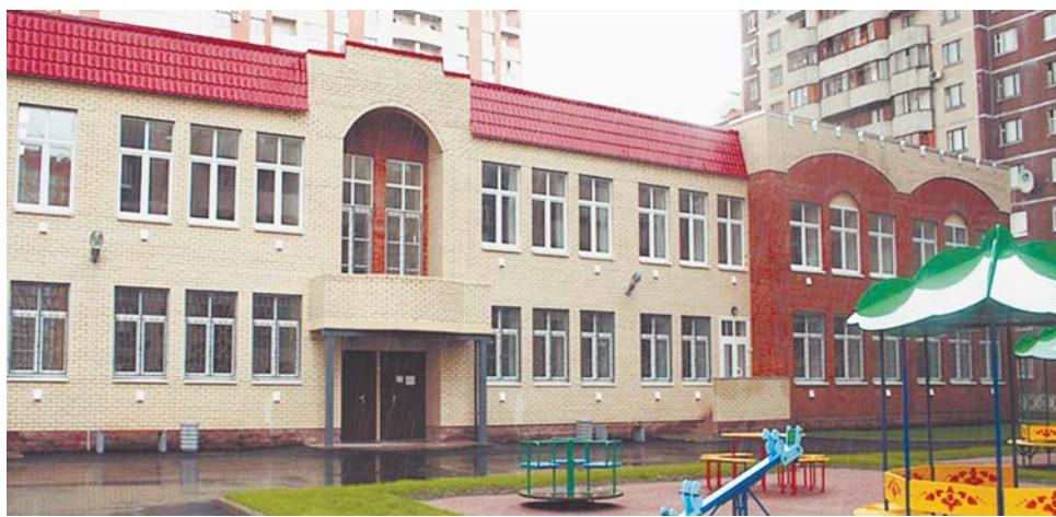
Строительство детского сада по адресу: Богатырский пр., 57, корп. 2
