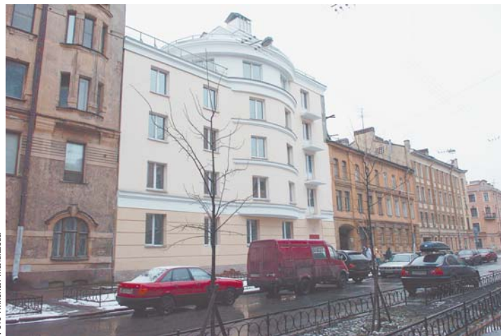
На 9-й Советской улице строительство жилого дома практически завершено
