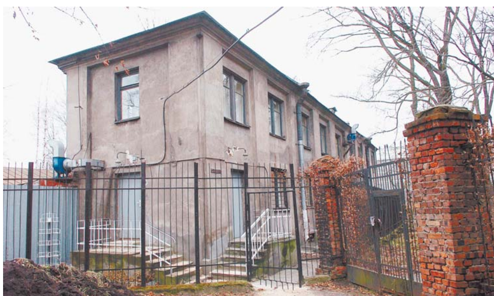
Сегодня на Университетской набережной, 7-9-11, корп. 5, лит. А находится двухэтажное ветхое здание бывшей водопроводной подстанции, не имеющее охранного статуса КГИОП
