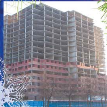
Поставка плит перекрытий для строительства жилого дома по безригельной технологии КУБ 2,5 -2006 год
