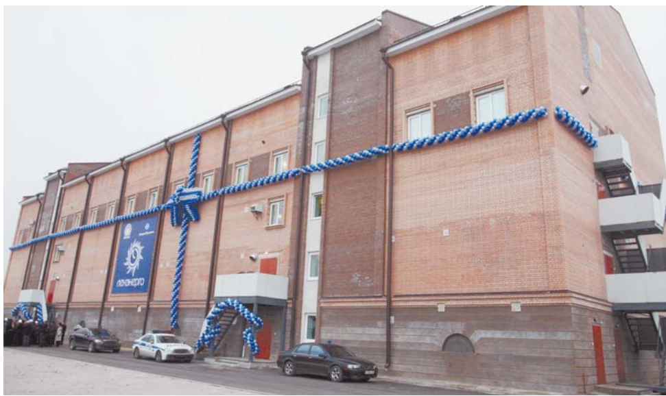
Электроподстанция «Лахта» на 110 кВ, построенная в рамках соглашения «Чубайс – Матвиенко», стала образцом того, как монополист может работать в интересах города
