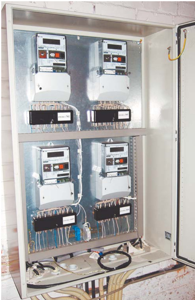
Автоматизированная информационно-измерительная система коммерческого учета электроэнергии (АИИС КУЭ)
