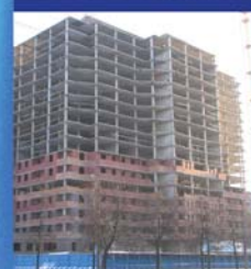
Поставка плит перекрытий для строительства жилого дома по безригельной технологии КУБ 2,5 2006-2007 годы
