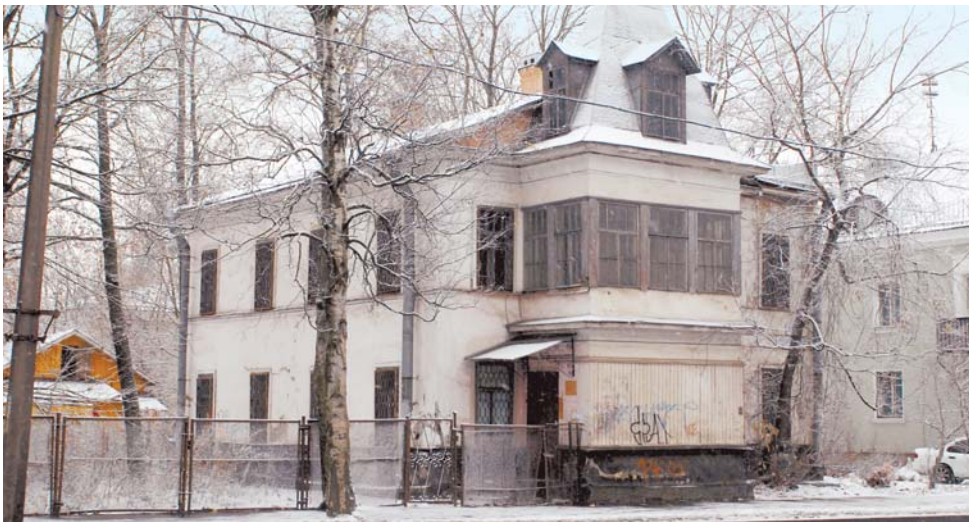
Школьная ул., 32, лит. А и Б — аварийные здания районной ветеринарной станции
