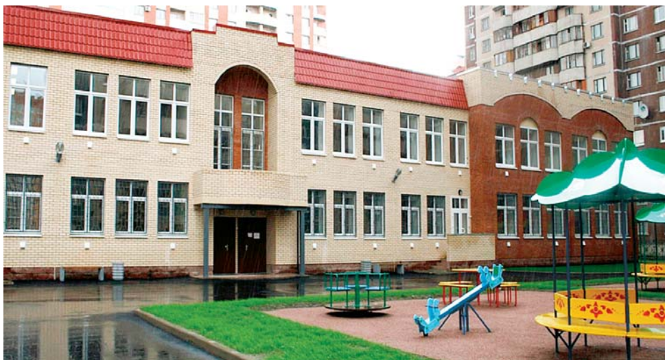
Строительство детского сада по адресу: Ситцевая улица, 3, корп. 2
