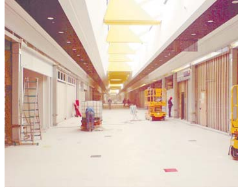
Коридор не разделен п.п перегородками
