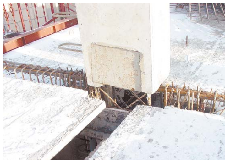
Узловое соединение колонна-ригель-плита
