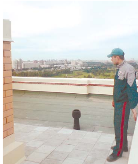
Эвакуация по кровле
