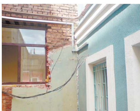
Проемы в противопожарных преградах
