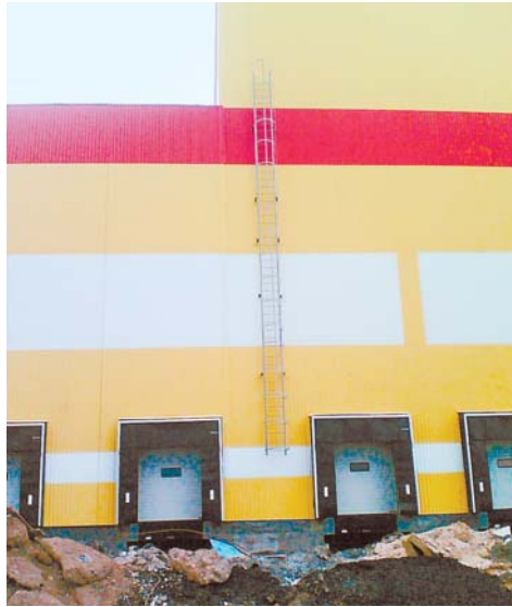
Пожарная лестница на кровлю
