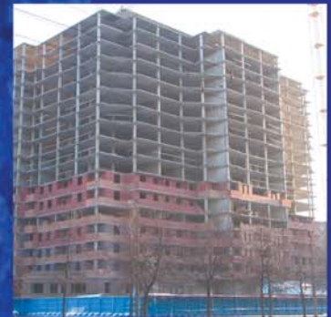
Поставка плит перекрытий для строительства жилого дома по безригельной технологии КУБ 2.5 -2006 год
