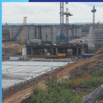
Поставка гидротехнического бетона и сложных арматурных каркасов – Комплекс защитных сооружений от наводнений (г.Кронштадт) – 2006-2007 год
