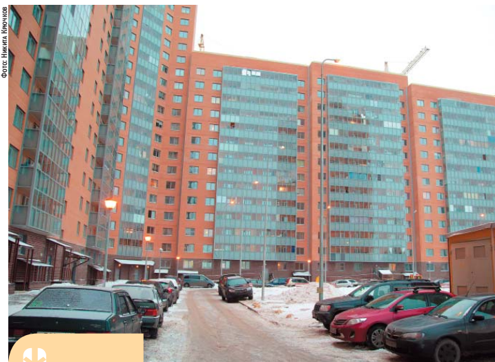
Сейчас в Мурино строится 26 многоквартирных домов высотой до 27 этажей
