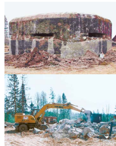
Демонтаж железобетонного дота в садоводстве
