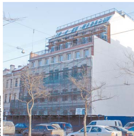
Здание по адресу: Лиговский пр., 150 реконструируется. Каркас готов
