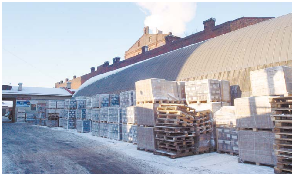
Складское здание на Лиговском пр., 273, лит. А – временные постройки
