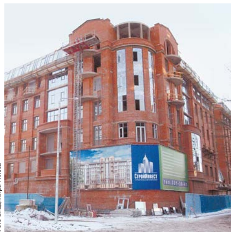
На Морском пр. ПС между домами 37 и 43 строится жилой дом. Каркас здания построен на 50 процентов
