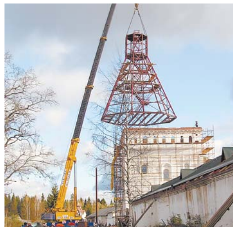
Монтаж шатровой части Никоновской башни Иверского монастыря
