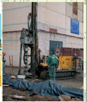
Технологическая карта ЗАО «Геострой» по устройству свай с использованием коротких проходных шнеков.
