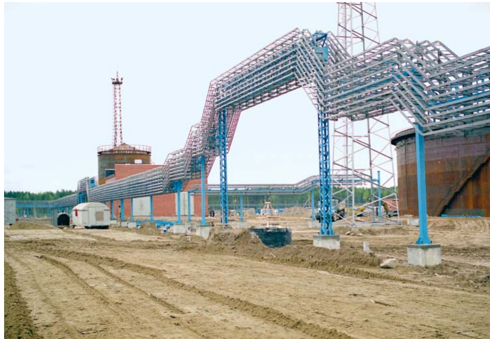
Приморский нефтеналивной терминал: кабельная эстакада (слева) и общий вид сооружений терминала
