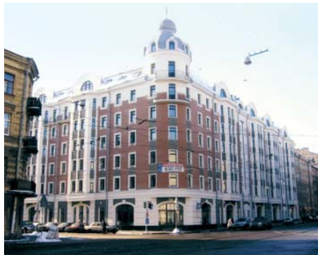
Жилой дом на Херсонской ул., 25–27
