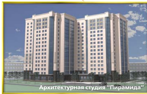
ул. Верности, ул. Карпинского
