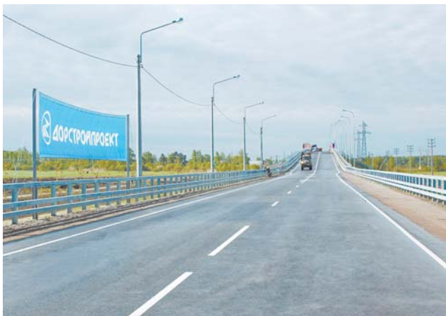
Участок Красносельского шоссе после реконструкции
