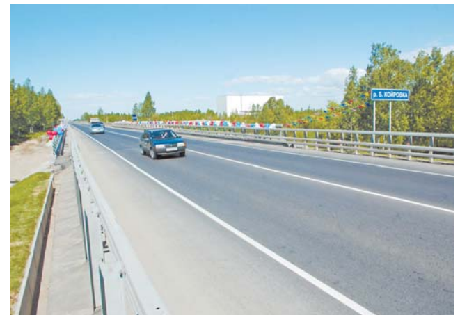
Реконструированный участок Волхонского шоссе
