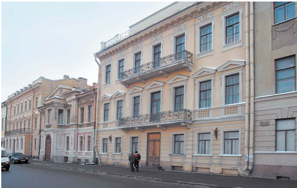
Электромеханический колледж должен покинуть здание на Английской набережной до начала учебного года.
