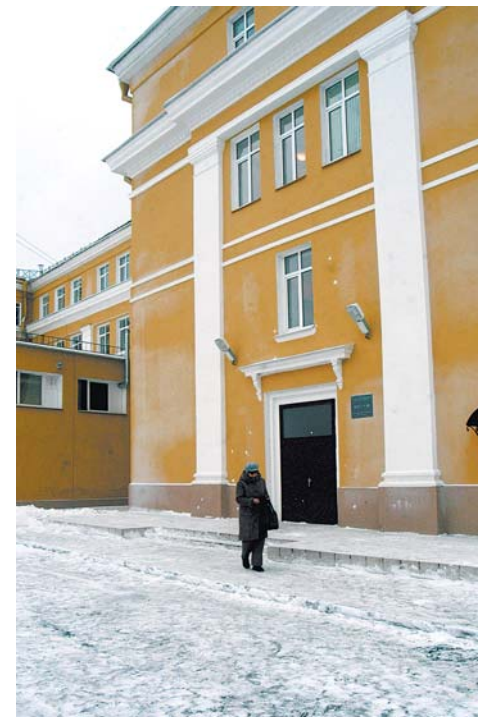
Городская школа №108 в Нейшлотском переулке
