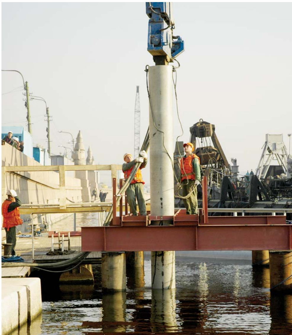
Мост Лейтенанта Шмидта заменит временная переправа. Первая свая моста-дублера уже забита. Сооружение временного моста предполагается завершить к началу навигации 2006 года.
