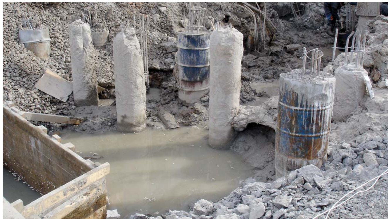
Процесс ликвидации размытия и наращивания свай
