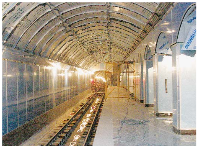
Средний зал. Пристанционный тоннель
