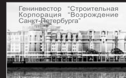
наб. РОБЕСПЬЕРА, 1 Срок сдачи: 1 оч. - II кв. 2005 2 оч. - IV кв. 2005
