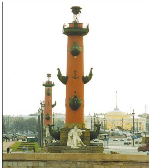
Обследование Ростральных колонн ЗАО «БЭСКИТ» провело по заданию Дирекции транспортного строительства и разрешения КГИОП.
