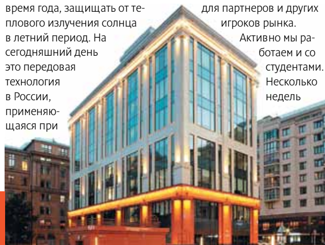
БЦ «Триколор ТВ», Санкт-Петербург (стекло Pilkington Suncool Optilam® 66/33)
